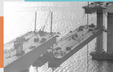
Figura 1.6 – Construção da Ponte Rio-Niterói. Fonte: (Disponível em: < http://arkprojetoestorias.com.br/inauguracao-da-ponte-rio-niteroi/ > Acesso em: 04 abr. 2020/13/11/ANTIGAS-XIV.jpg> Acesso em: 24 out. 2019)
