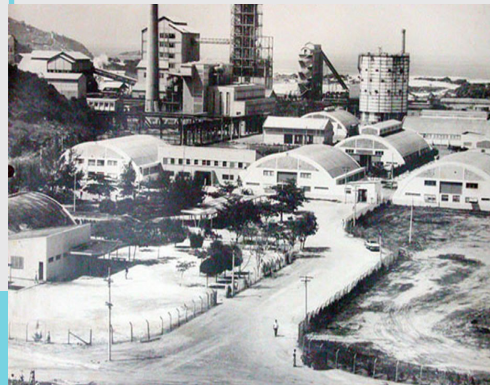
Figura 1.5 – Instalações da Companhia Nacional de Alcalis. Fonte: (Disponível em: < http://arraial.web955.uni5.net/wp-content/uploads/2013/11/ANTIGAS-XIV.jpg > Acesso em: 24 out. 2019)
