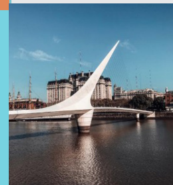
Figura 2.26 Vista da Puente de La Mujer, símbolo da revitalização do Puerto Madero. (Fonte: Acervo pessoal)
